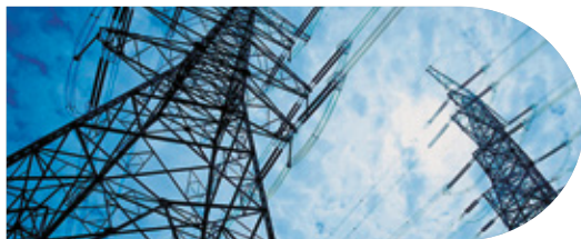
ПЕРЕДАЧА И РАСПРЕДЕЛЕНИЕ ЭЛЕКТРОЭНЕРГИИ
