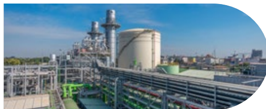
ПРОИЗВОДСТВО ЭЛЕКТРОЭНЕРГИИ И ОЧИСТКА ВОДЫ
