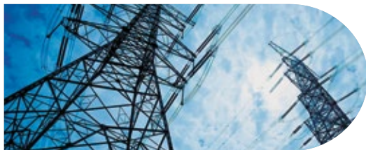
ПЕРЕДАЧА И РАСПРЕДЕЛЕНИЕ ЭЛЕКТРОЭНЕРГИИ
