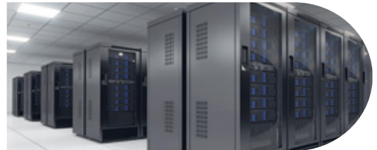
GRANDI DATA CENTER
